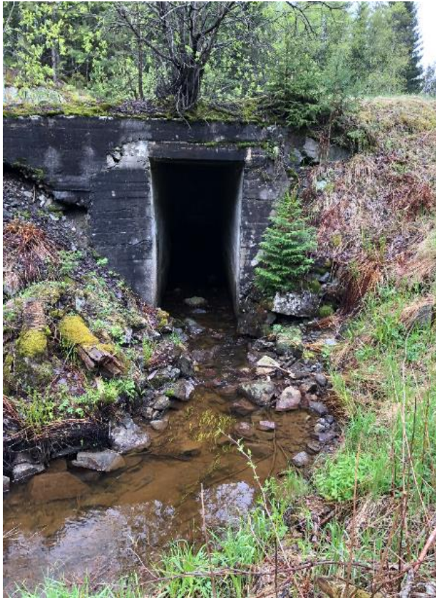
Figur 4-1 : Foto av eksisterende oppstrøms kulvert under Langangvegen
