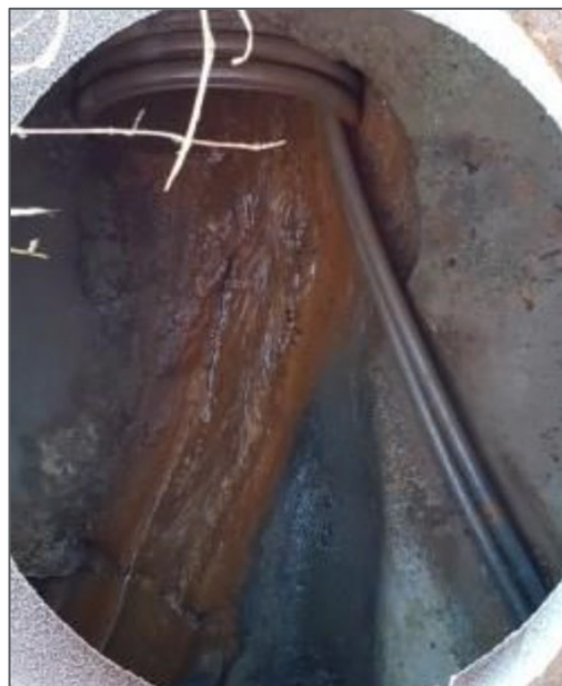
Figur 19: Kumbilde av kum 99915 i Pasadalen. Bildet viser at OV400PVC videreføres, antatt til OV1000BET. (Gemini).
