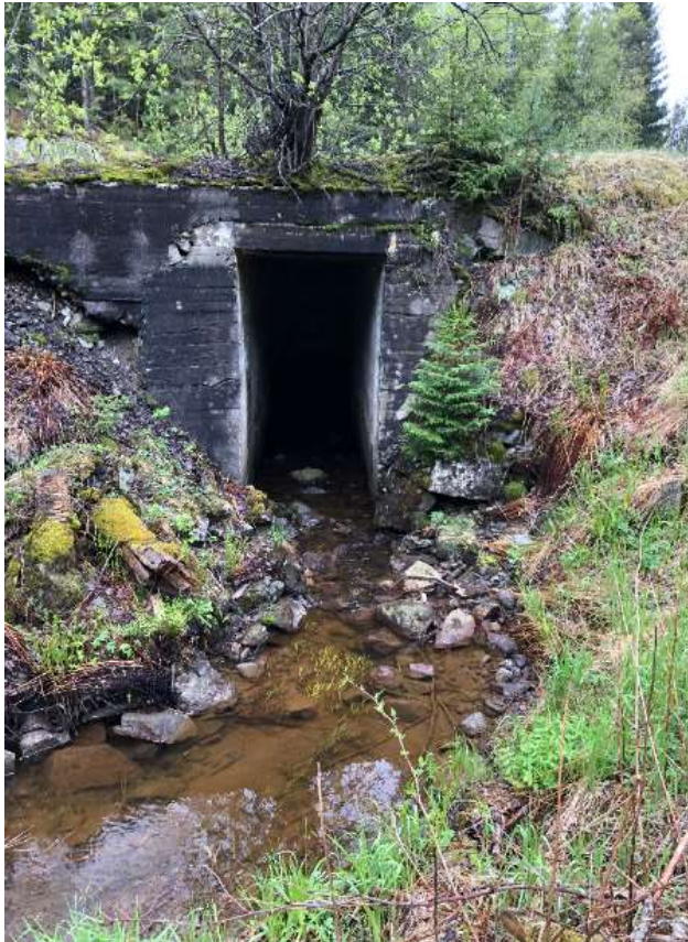
Figur 4-1 : Foto av eksisterende oppstrøms kulvert under Langangvegen
