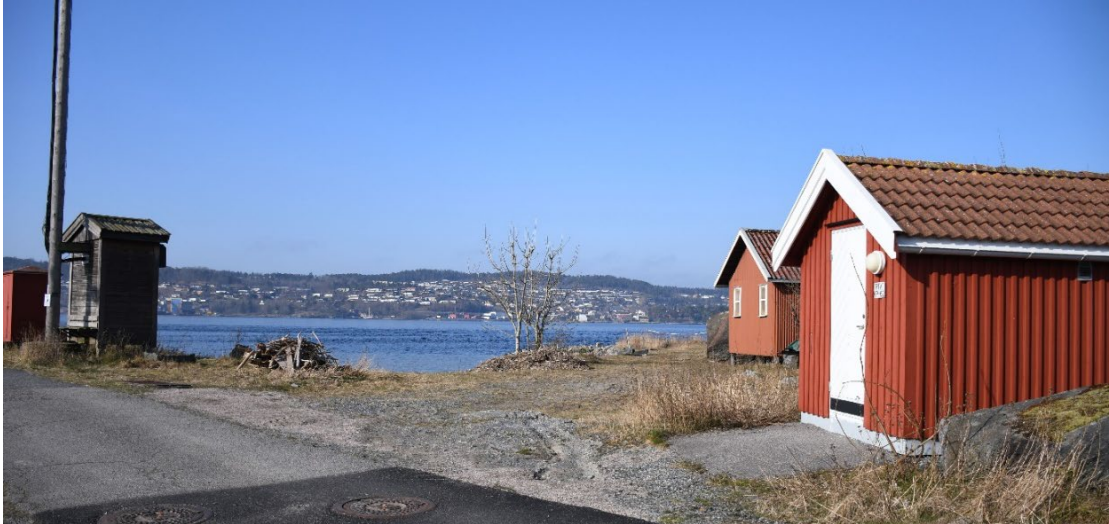
Figur 16: Pumpehus og mobilmast
