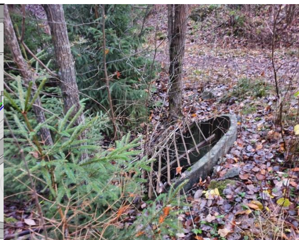
Innløp overvann – diameter 0,9 m.
