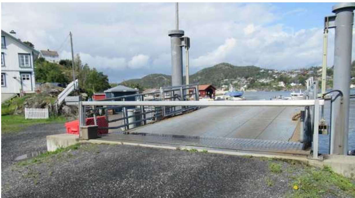
Figur 24: eksempel på hydraulikk-stolper til fergelem
