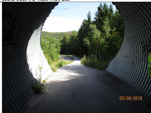
Figur 14. Gangkulvert sett mot Moheim
