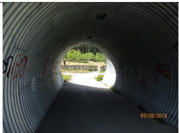
Figur 15. Gangkulvert sett mot Eidanger kirkegård
