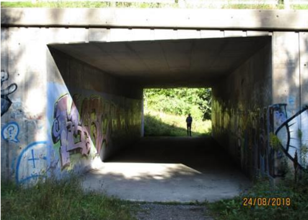
Figur 17. Alternativ 3C. Eksisterende kulvert under E18.
