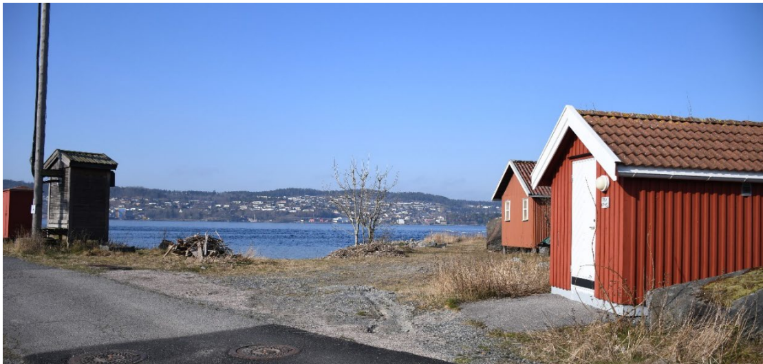
Figur 16: Pumpehus og mobilmast
