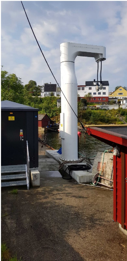
Figur 3: Foto av trafo og ladetårn på kai samt tilkoblingen om bord på hoveddekk.
