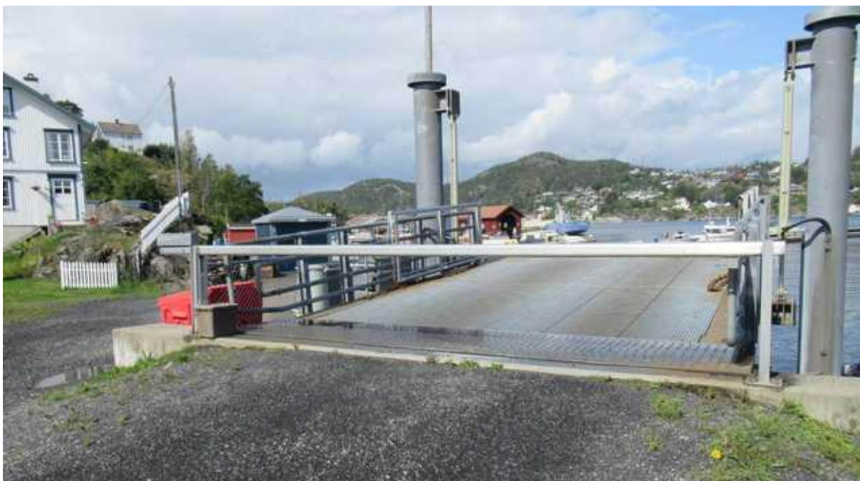
Figur 15: eksempel på hydraulikk-stolper til fergelem
