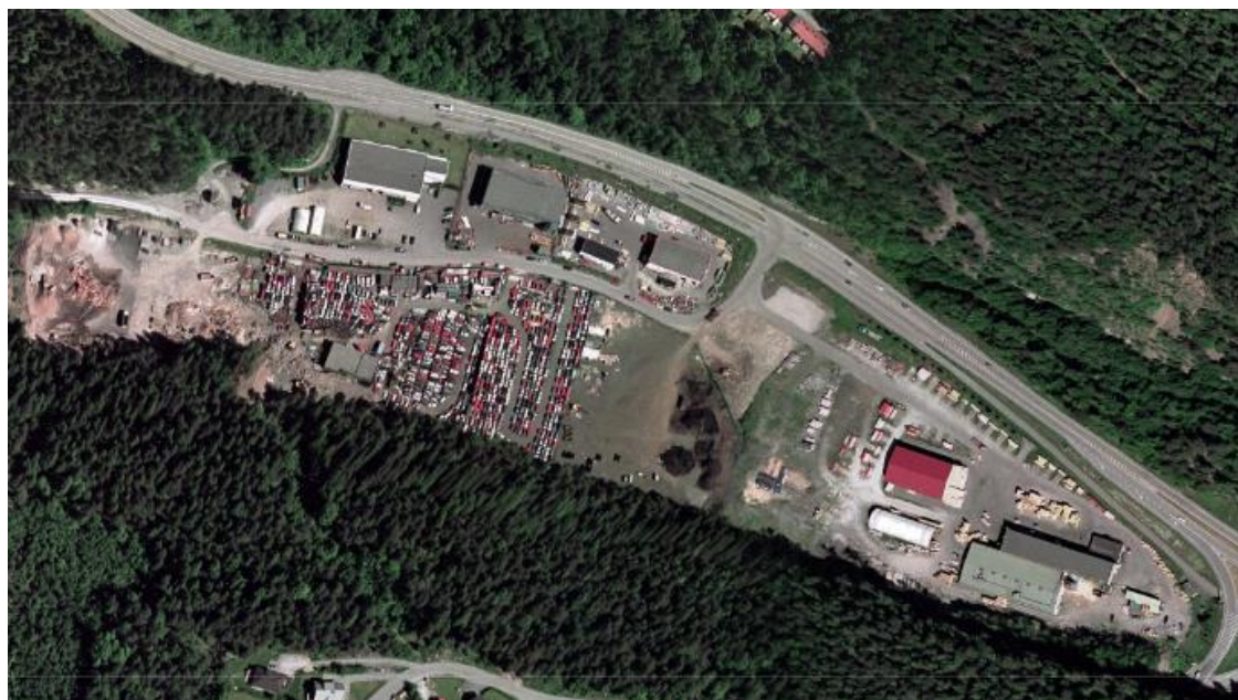
Figur 5: Flyfoto av næringsarealene fra 2002. Bildet viser Eramets deponi (i midten) som er i ferd med å avsluttes. Det vises også en del masseuttak/-lagring helt vest på området, ved de delene som vil bli berørt av planområdet. Kartgrunnlag: 1881.no/kart
