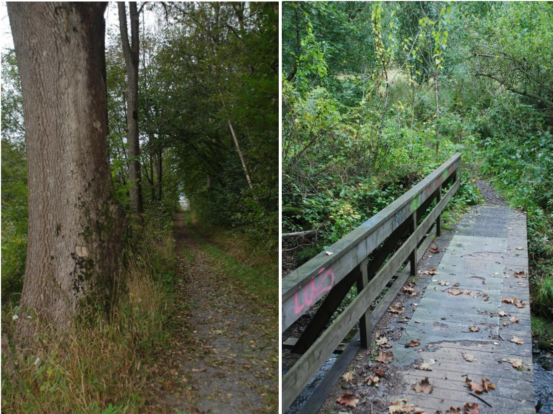
Figur 5-5 Til venstre: Nedre del av Versvikvegen blir turvei. Til høyre: bru over Versvikbekken, del av Frierstien
