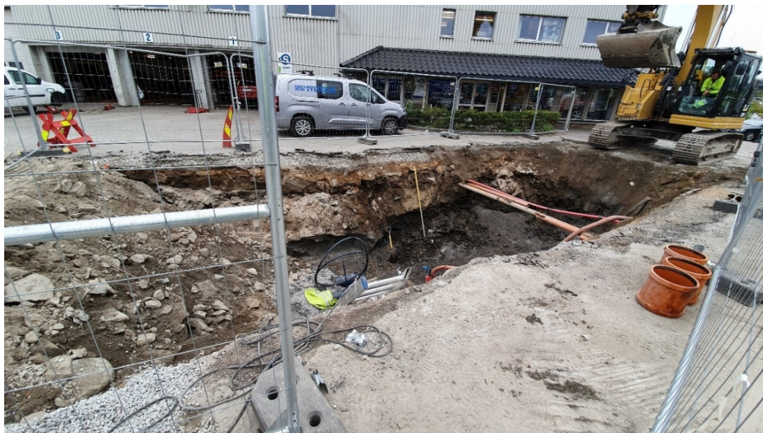
Figur 4. Bilde av grop. Dybde ble målt til ca. 2,2 m.
