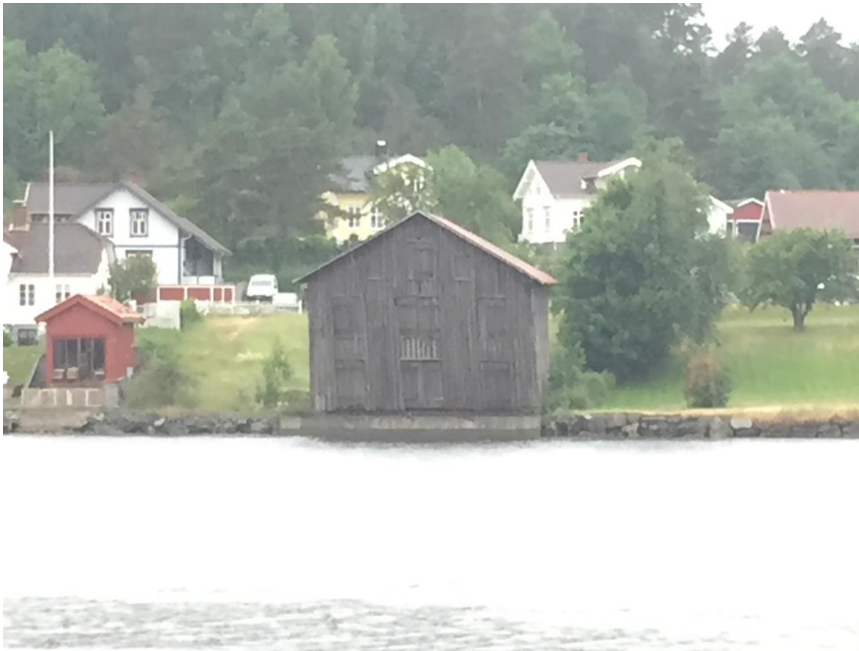
Fig. 7 – Sjøbua i dagens situasjon, sett fra østre bredd.
