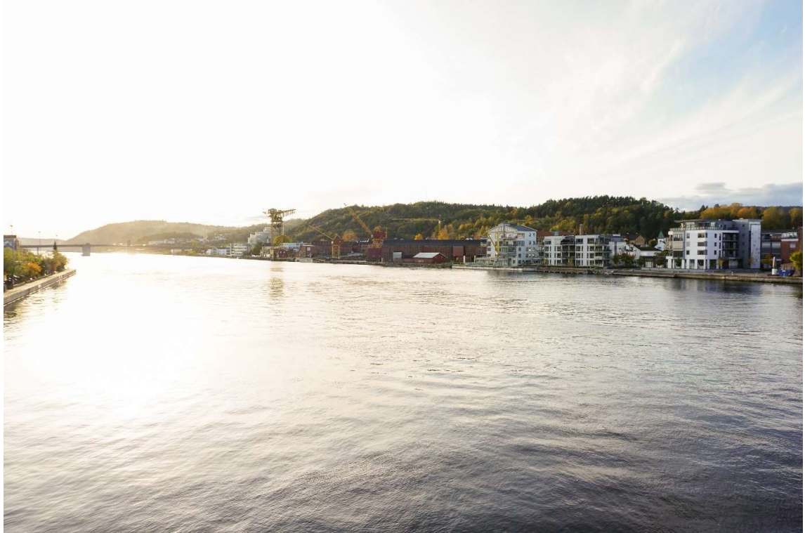
figur 7.2 – PMV-området sett fra østre ende av Porsgrunnsbrua. Foto 14.10.19. Supplyskip er ikke lenger ved kai, og Powerhouse er under oppføring (bak Utrustningskrana).
