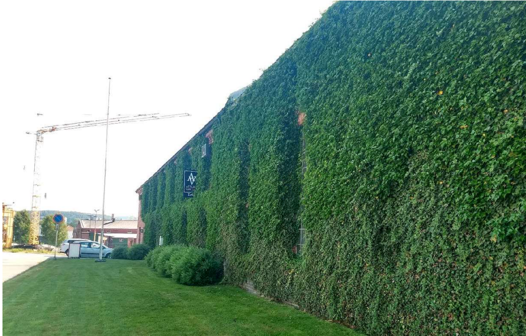
figur 6.2 - villvin på nordfasade av Kontorbygget
