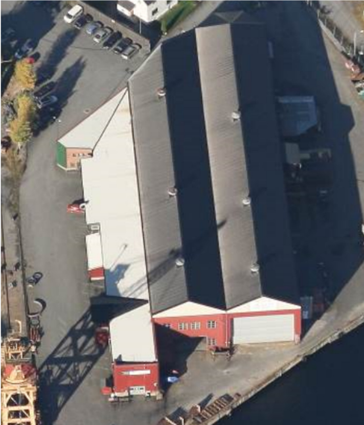
Foto nr. 3 Fasade sør
