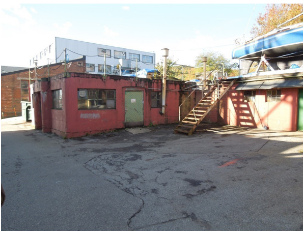
Foto nr. 22 Teknisk rom til venstre, garderobe wc til høyre
