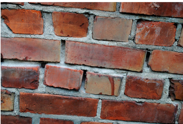
Foto nr. 9 Gavlvegg mot vest.
