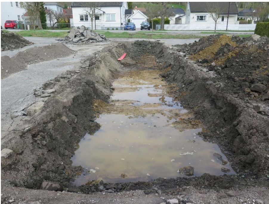
Figur 10. Sjakt 3. Tatt mot NV.
