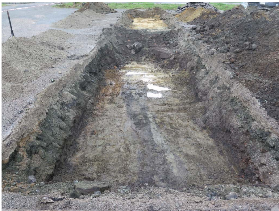
Figur 8. Sjakt 1. Tatt mot NV.
