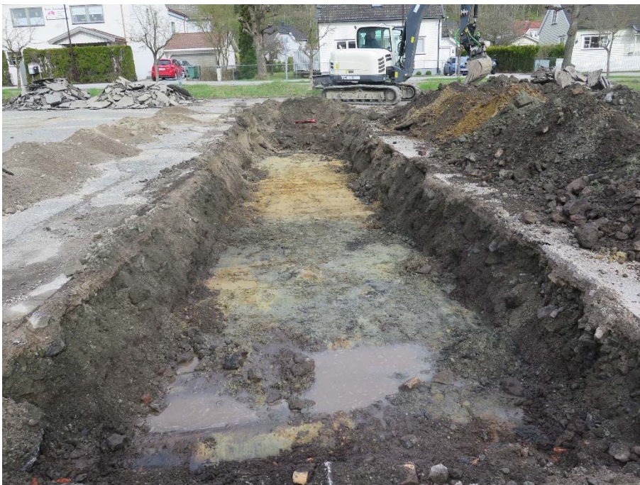
Figur 9. Sjakt 2. Tatt mot NV.
