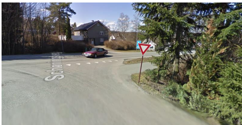
Figur 1 Frisiktsforholdene fra Schöningsveg mot nord i Ullinvegen er utfordrende grunnet trær/vegetasjon.
