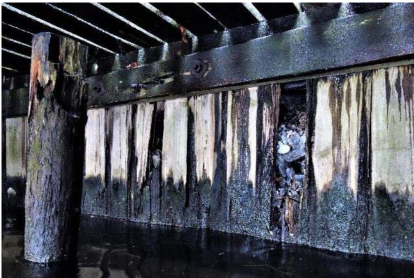
Figur 31: Nedbruten spont över vattenytan.
