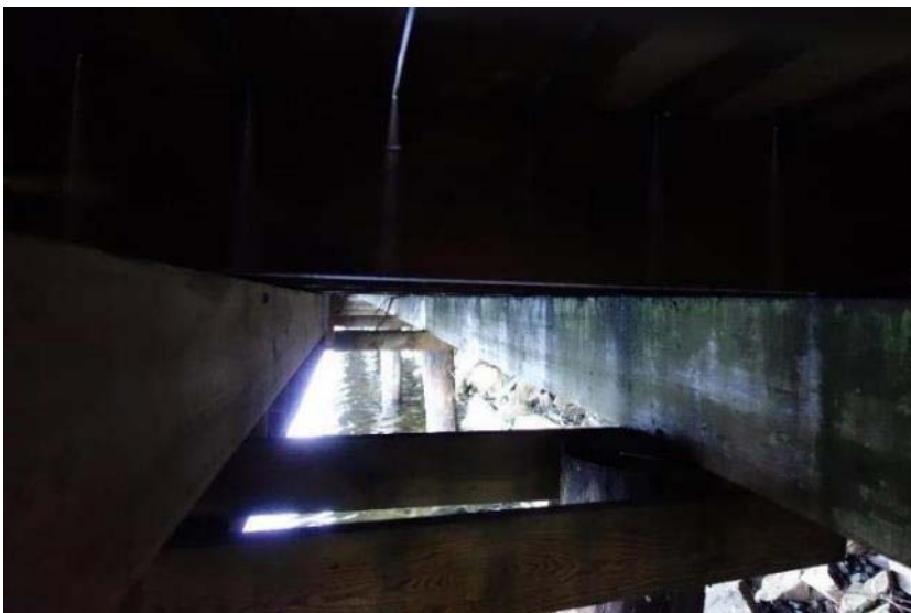
Figur 6: Längsgående träbalkar upplagda på avvaxlingar mot träpålar.
