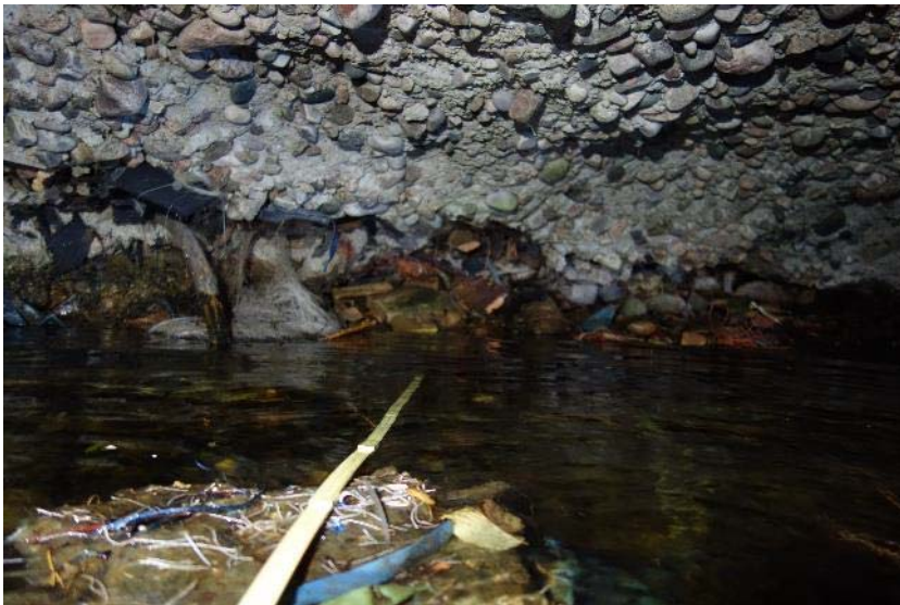
Figur 23: Omfattande urspolning tvärs inre delen av kajdäck.
