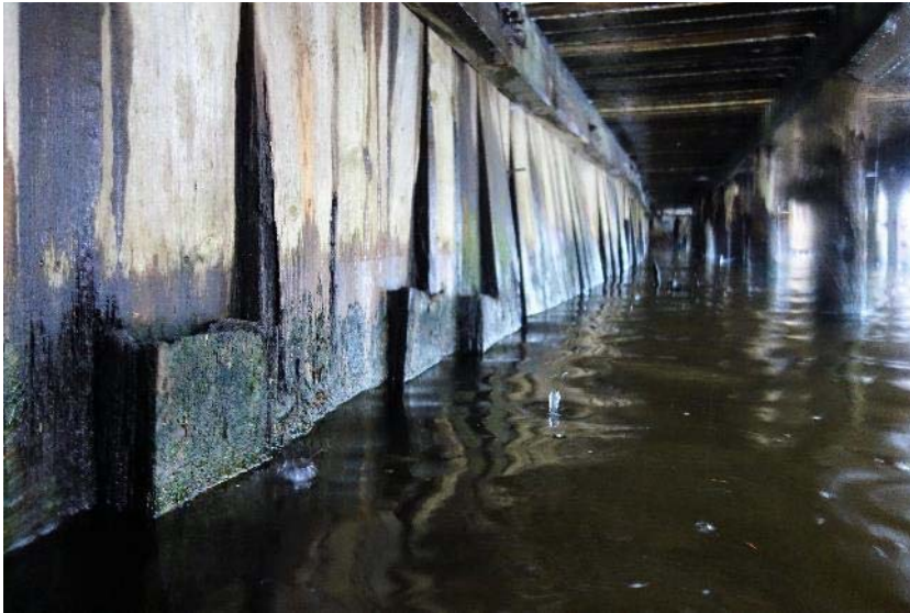
Figur 30: Träspont av stående plank.
