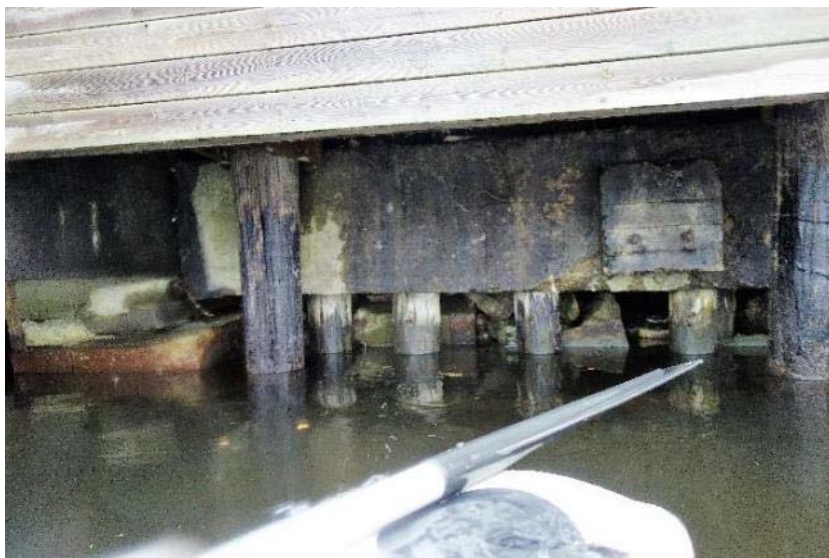
Figur 7: Frontbalk av betong.
