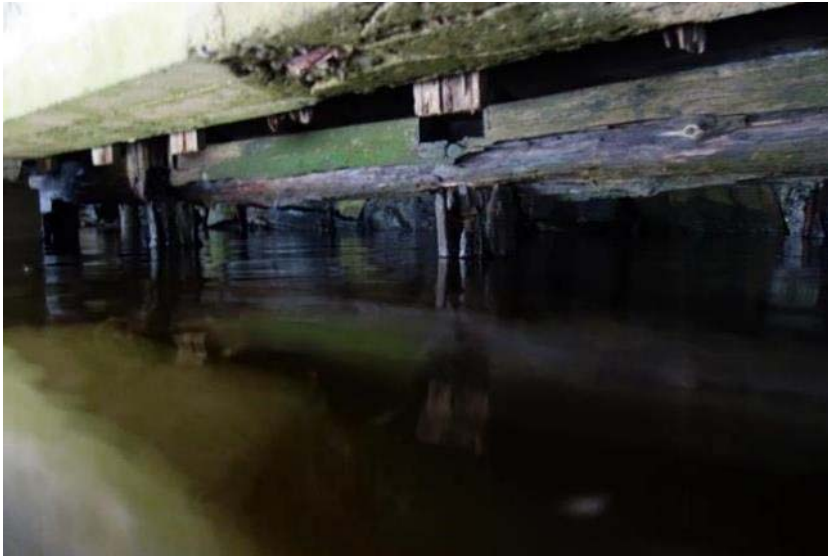
Figur 14: Kvarlämnad form under inre fack samt bakkantsmur av sten.
