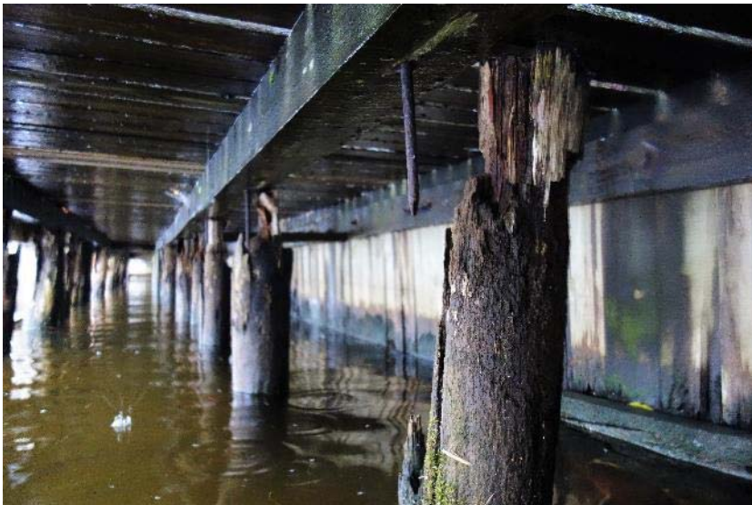
Figur 29: Rad om tretton pålar som inte bär upp primärbalk.
