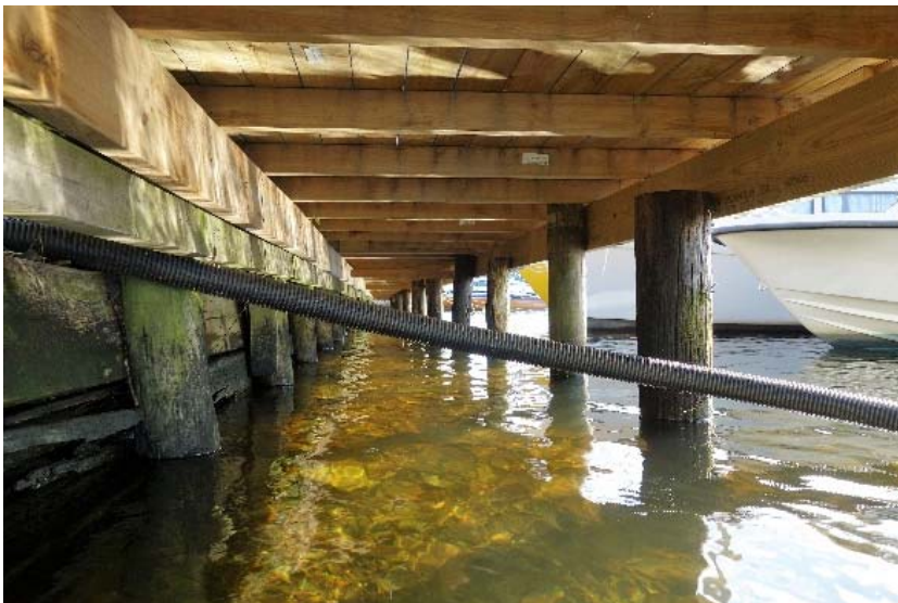
Figur 88: Nytt trädäck på befintliga pålar och träspont.
