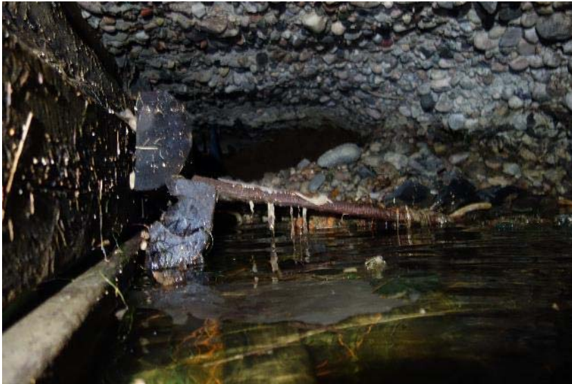
Figur 22: Omfattande urspolning längs inre delen av kajdäck.
