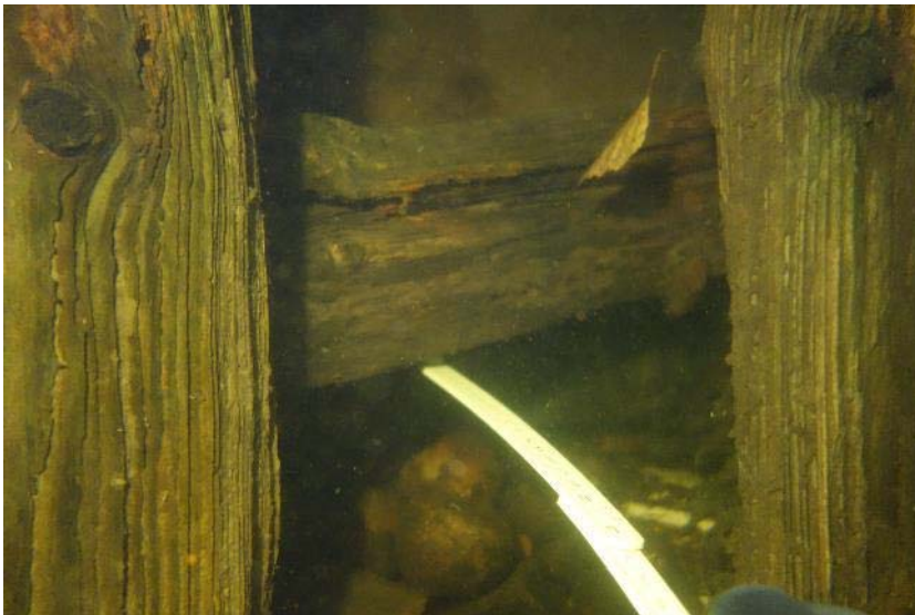
Figur 25: Skadad skyddsspont.
