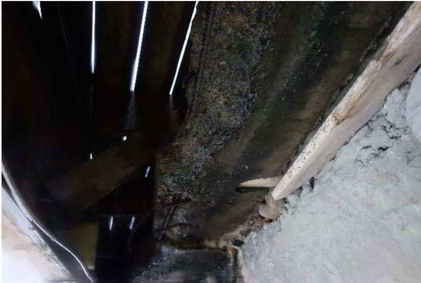
Figur 20: Konsol av platta utanför frontbalk.
