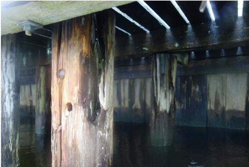
Figur 28: Skadade påltoppar.
