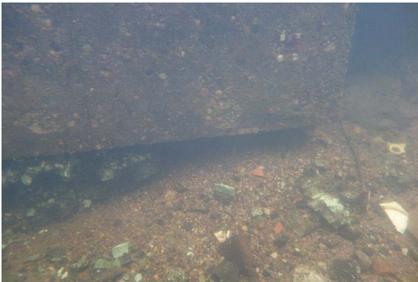
Figur 62: Urspolning under L-stöd.
