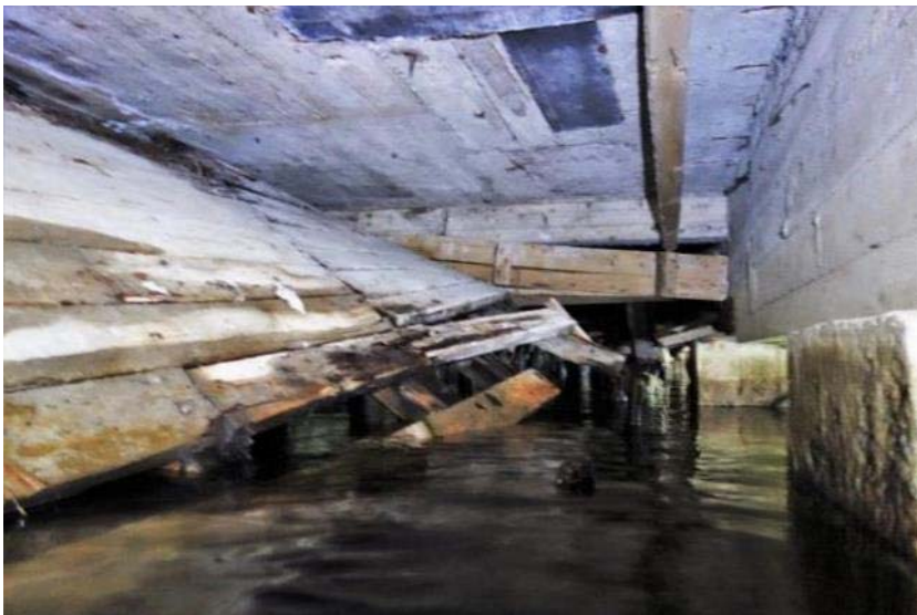
Figur 13: Inre fack med kvarlämnad form av tidigare kaj.
