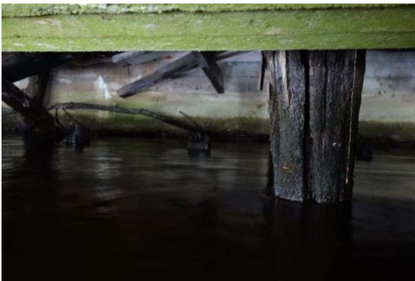
Figur 19: Äldre overksamma pålar samt bakkantsmur av betong.
