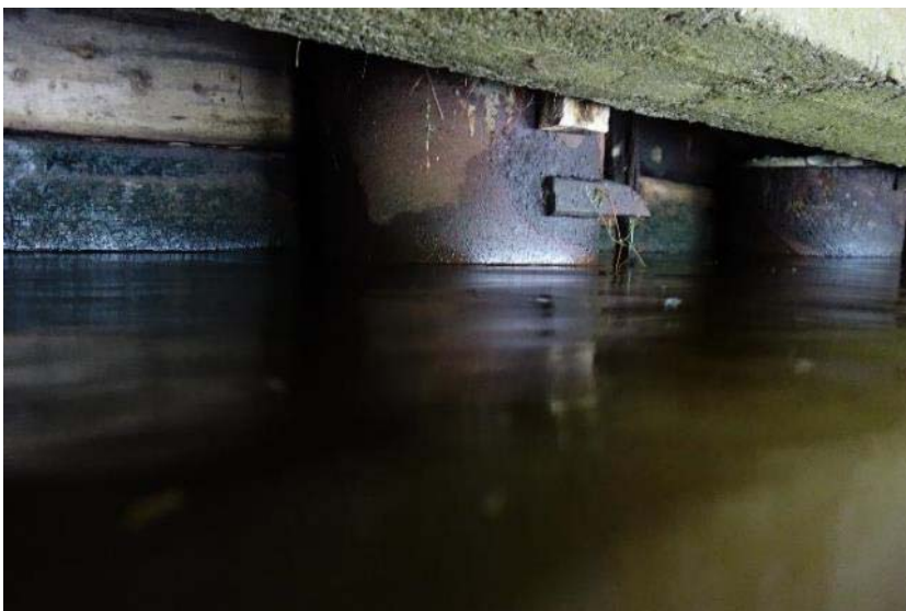
Figur 21: Betongpålar med isskydd av stålplåt.
