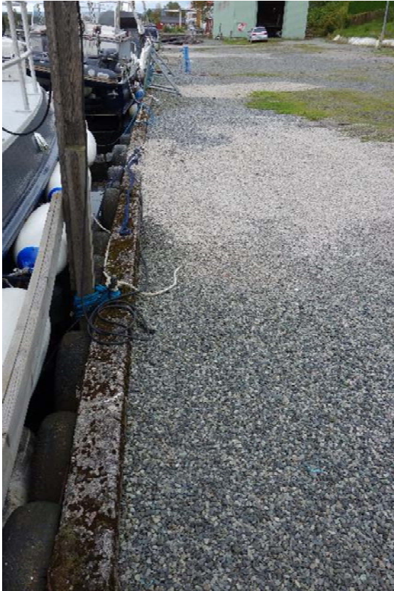
Figur 40: Återfyllningar av mark bakom kaj.
