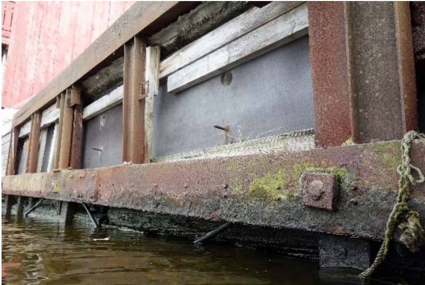
Figur 69: Frontmur av betong med utanpåliggande stålkonstruktion.
