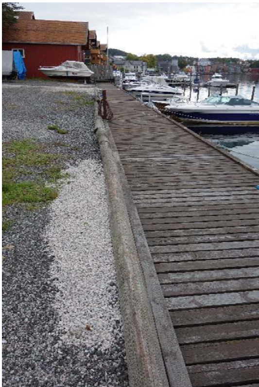
Figur 33: Återfyllning av stenmaterial.
