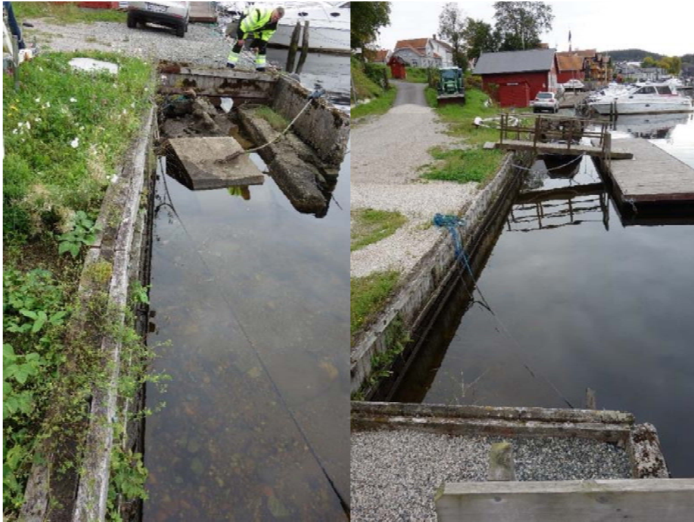
Figur 36: Spontkaj av trä med rester av äldre kajpartier.
