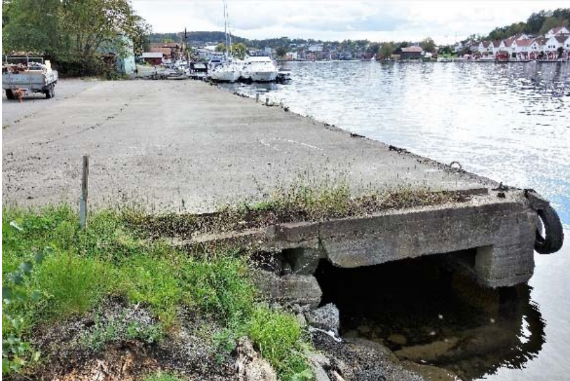
Figur 56: Norra änden av Kajdel 2-4 Norra.
