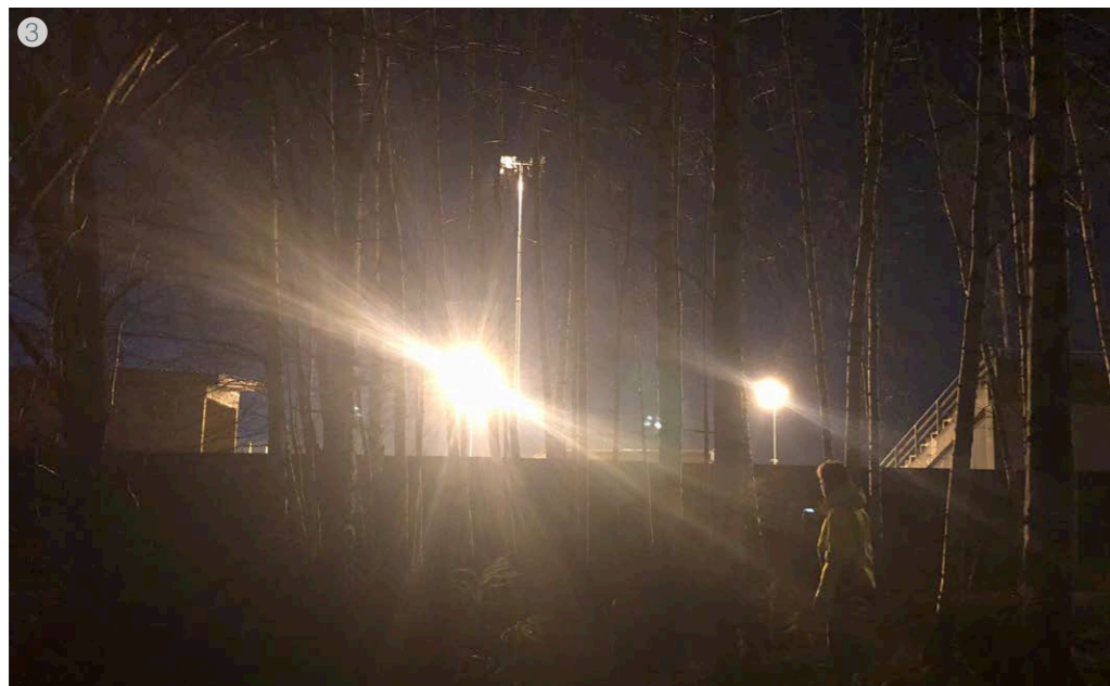
Armaturer plassert på motstående langside av Pors Stadion oppleves blendende. Muren mellom tomten og Stadion samt trær bidrar til å redusere mengden lys som treffer tomten. En bedre optisk styring av lyset (nye armaturer / fokusering) vil bidra til å redusere både blanding og strølys. Dersom belysning på Pors Stadion ikke utbedres/fokuseres bedre, anbefales det å beholde trær i størst mulig grad og prioritere at hovedandelen av oppholdsrom ikke vender mot stadion.
