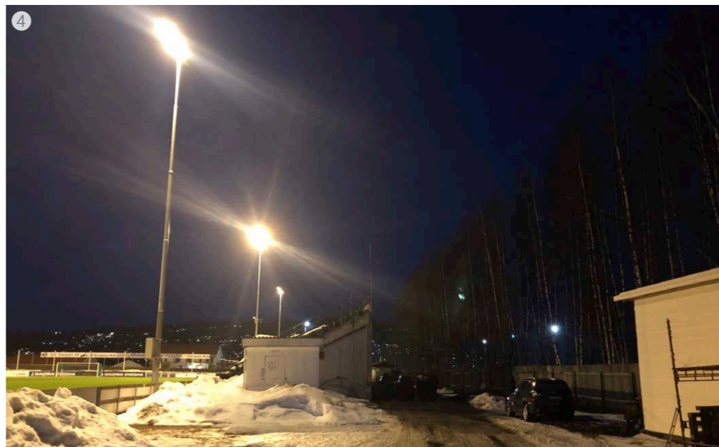
Belysning av Pors Stadion gjøres i dag av flomlyskastere montert på mast med en høytrykk natrium lyskilde. Lykildene er store i størrelse og avgir et varmt lys (2600-3000K) og har en lav fargegjenivelse på omtrent RA 40. Lykildenes store størrelse gjør armaturen mindre presis og det vil forekomme utilsikket strølys. Med LED som en mer etablert lyskilde med lang levetid og fordeler med tanke på energiforbruk, levetid, optisk presisjon og fargegjenivelse er det sannsynlig at belysningen av Pors Stadion vil oppgraderes over tid.
