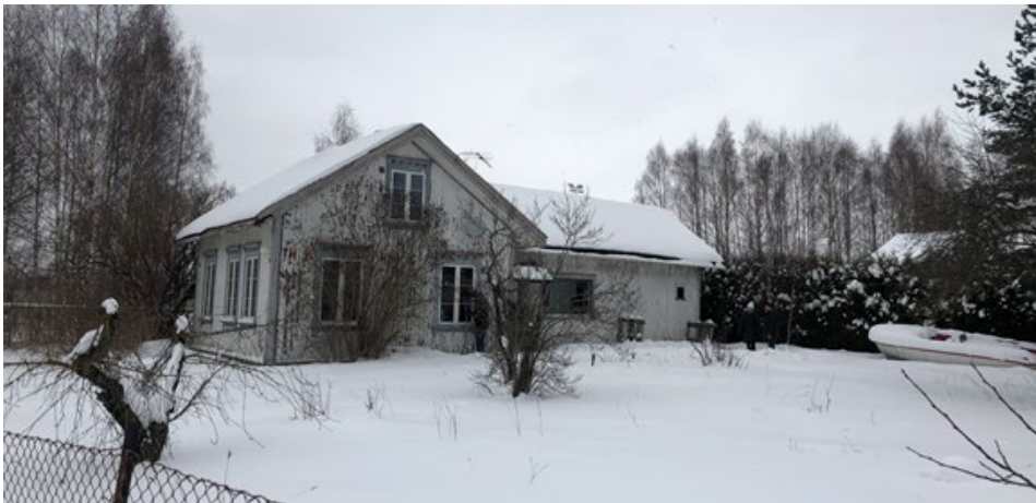
Opprinnelig bolighus (til venstre i bildet) langs Fredbovegen
