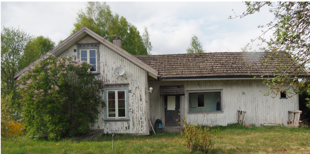
Fredbovegen 61, boligdel til venstre, tilbygget til høyre
